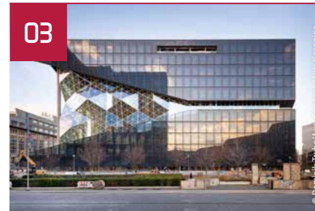
03 Referenzen „HST“ Axel Springer Berlin 4 St. Anlagen 590 kW + 1.050 kW
